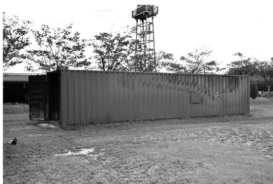
(写真 8) (実火災体験型訓練施設)
